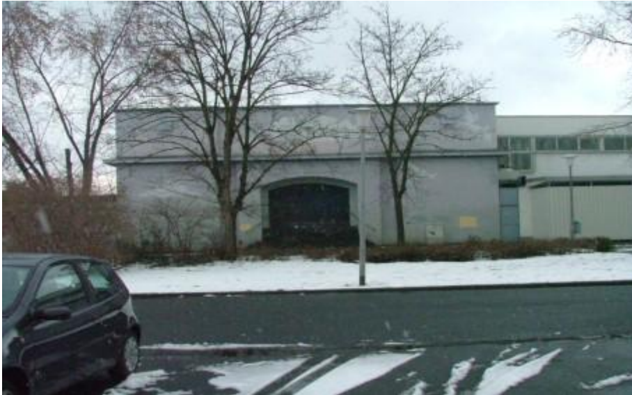
Frontansicht des Schönauer Bunkers
